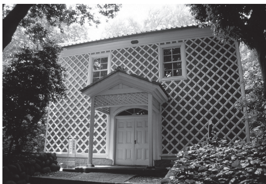
fig. 1 演説館(1874年竣工)
